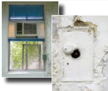
透過窗戶旁邊捲動的裝置，鐵捲窗可上下捲動，此兩張照片為目前的現況，右圖為控制鐵捲窗上下捲動的裝置，但功能已消失。(蘇芷萱攝)
