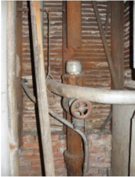
位於東側一樓的消防管道間，因為漆喰壁之背面體而直接看到木摺的部分。(蘇芷萱攝)
