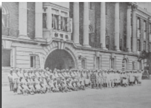
此二張照片可以看出遞信部二樓陽台原為落地窗的設計，並可向外推出。（翻拍自中央圖書館臺灣分館《臺灣遞信協會雜誌》）
