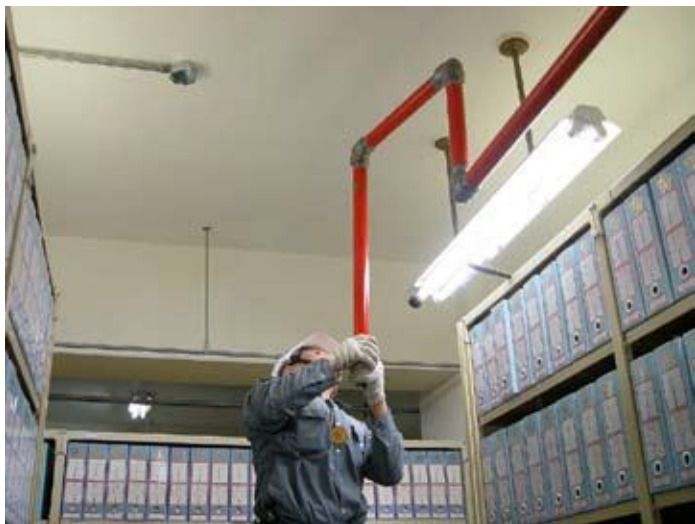
●FM200自動滅火系統施工 (王希智 攝)
