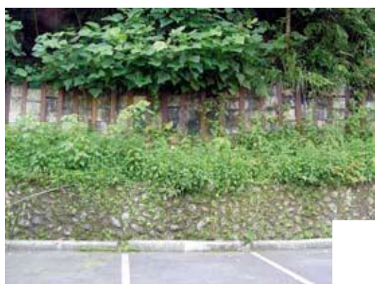
●原設計使用之鋼軌樁擋土牆 (王希智 攝)
