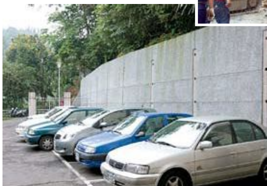
●重力式鋼筋混凝土擋土牆 —完工使用 (王希智 攝)
