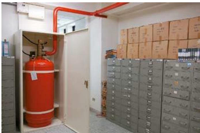
●FM200自動滅火系統—藥 劑鋼瓶(王希智 攝)
