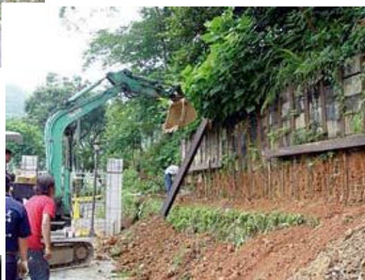
●重力式鋼筋混凝土擋土牆—施工 (王希智 攝)
