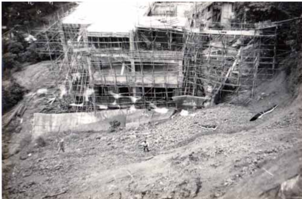
圖4：1972年5月修建中的行政大樓左側山坡塌方
